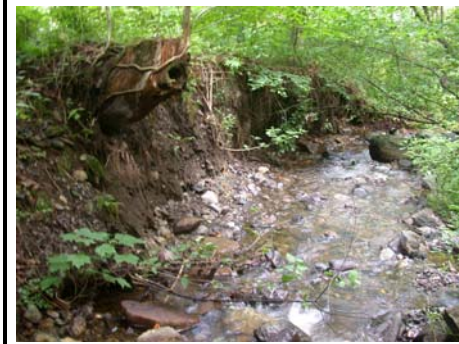
Pt 20: forte érosion de talus
