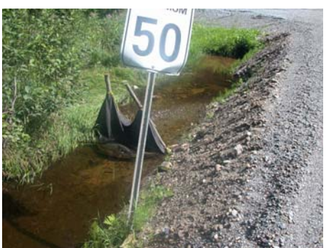
Pt 3 : barrière à sédiments, coin Nord-Est de l'intersection
