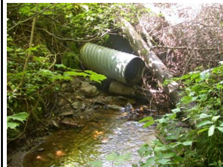
Pt 26: minage sous un ponceau
