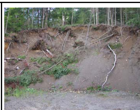
Pt B2: excavation de sols
