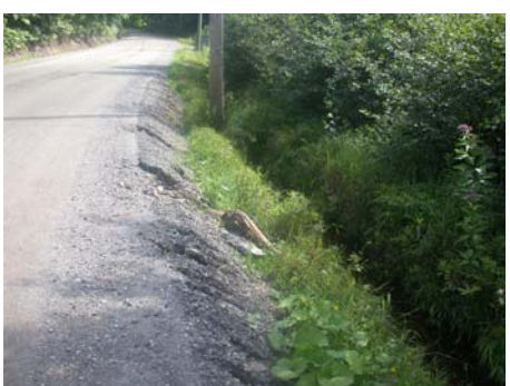
Pt 4: minage de la route
