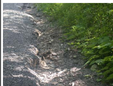
Pt 7: minage de la route
