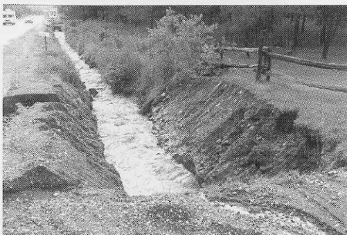
Photographie no 2 : Début de section nettoyée selon la méthode traditionnelle pour les premiers mètres, puis selon la méthode du tiers inférieur pour le reste. La photographie a été prise lors de la période de fortes précipitations de la mi-juillet 1996 et moins d'une semaine après l'intervention de nettoyage du fossé. Remarquer la forte érosion déjà en place dans les premiers mètres alors que la partie creusée selon la méthode du tiers inférieur est demeurée presque intacte. (Route 222-01-120, vue vers le sud-est) (Photo RAPPEL, 96-07-12)
