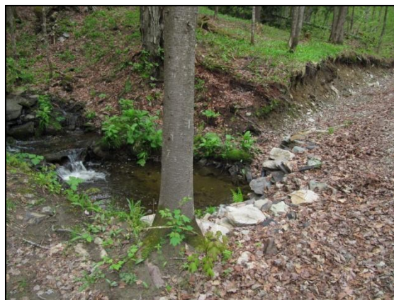
Point 6 : Connexion direct du fossé au réseau hydrographique.
