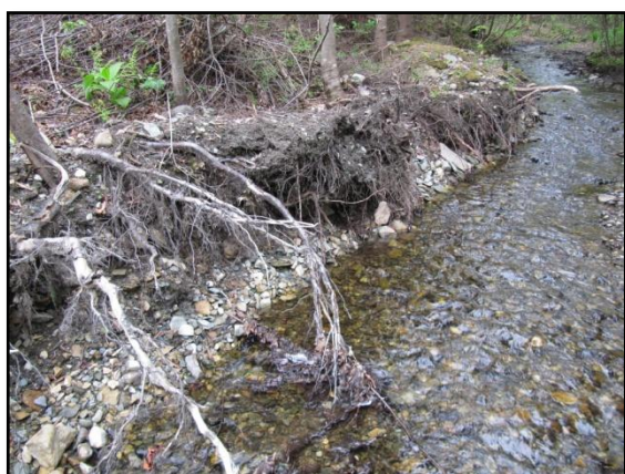
Point I : Affouillement du pied de la berge et nombreuses racines à nu sur la rive droite en amont du ponceau.
